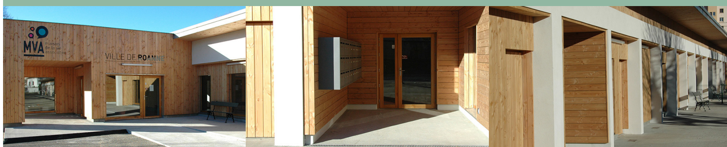
Les façades bois ont été posées à l'intérieur de la structure existante
