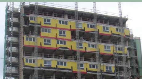
Des façades bois préfabriquées sont posées sur les extensions de plancher
