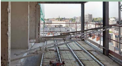
Des poutres métalliques horizontales sont fixées sur les murs existants et portent une extension du plancher
