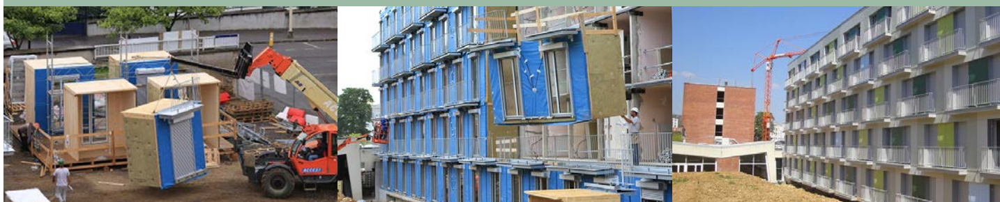
Les cellules d'agrandissement sont préfabriquées et amenées sur le chantier
