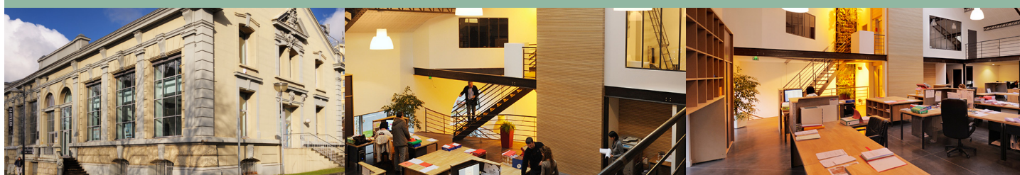
Le bâtiment après réhabilitation
