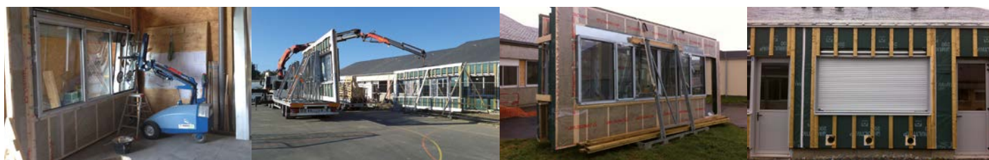
Mise en place en atelier de la menuiserie dans une façade en ossature bois - LCA ©
