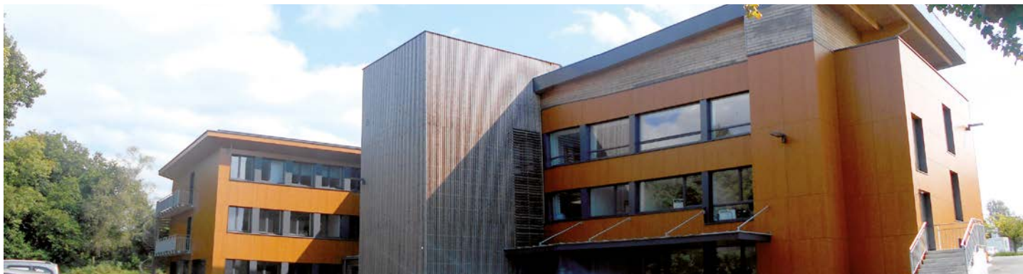
Aperçu façade Nord. L'adjonction d'une cage d'escalier et d'ascenseur avec bardage verticale a pris le parti d'une rupture d'écriture architecturale. Trois Architectes ©
