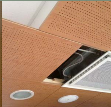
Plénum technique et acoustique en panneaux de fibre de bois. / Abibois ©
