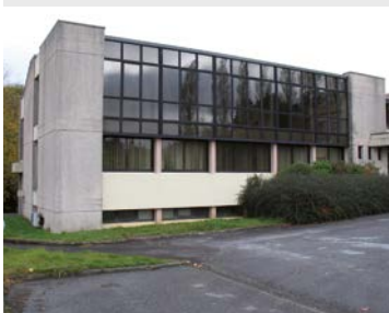
Avant travaux. Trois Architectes ©
