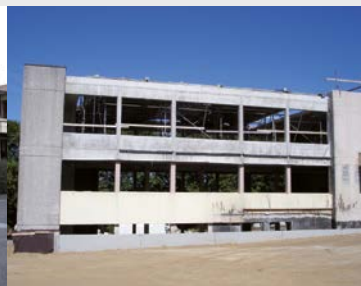
Façade déposée + ouverture de la toiture. Trois Architectes ©
