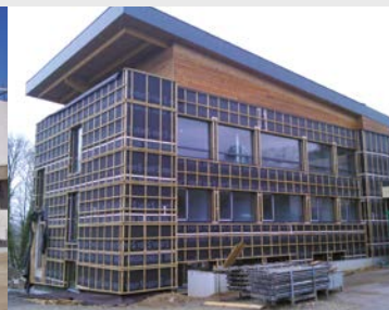
Réhausse + façade bois. Trois Architectes ©
