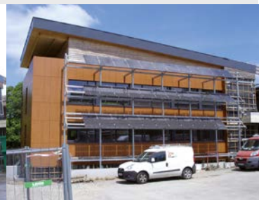
Bardage + brise soleil photovoltaïque. Trois Architectes ©
