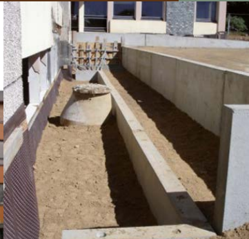
ITE + ouvertures en soubassement. Trois Architectes ©
