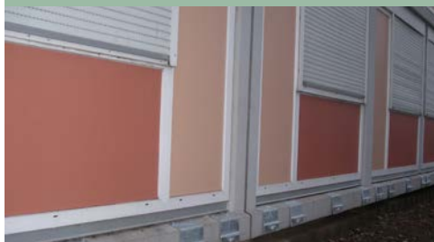
Pose des panneaux préfabriqués revêtus d'un polyane de protection.
