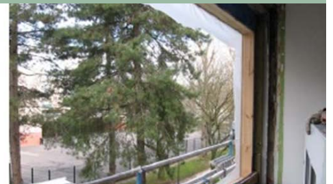
3 - Pose de la nouvelle menuiserie
