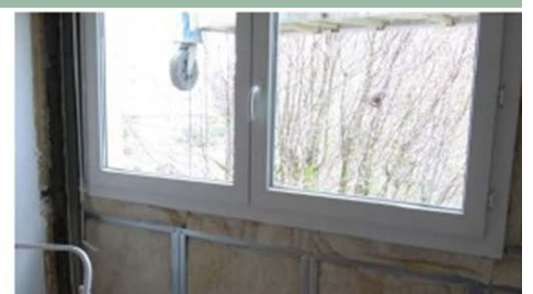
4 - Pose de l'isolation
