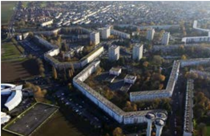
Vue d'ensemble, Quartier La Fauconnière. 2 500 logements.
