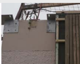
Ferrures fixées sur l'acrotère, en attente de recevoir les panneaux.
