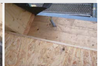
Plancher caisson et mur ossature posés sur la lisse de ceinturage, liaison par goujon en attente.
