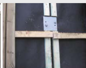
Liaison entre panneaux par platine se faisant sur la face extérieure du panneau. Puis 4 lames de raccord seront posées sur chantier.
