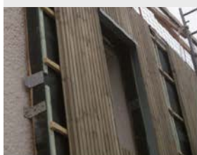
Fixation à mi-hauteur des panneaux par équerre afin de les reprendre sur le mur existant.
