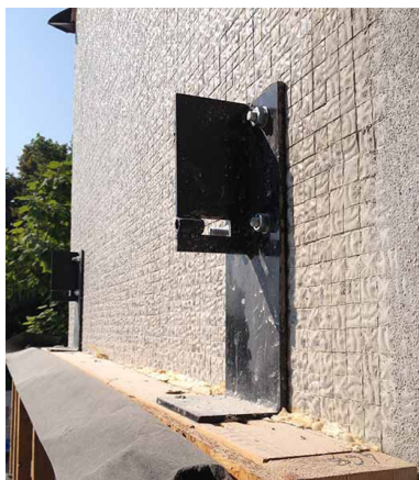
Fixation d'une platine sur la pâte de verre
