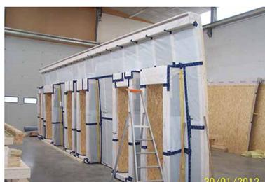
Les façades galbées sont réalisées en atelier, avec l'isolant et le pare-vapeur.
